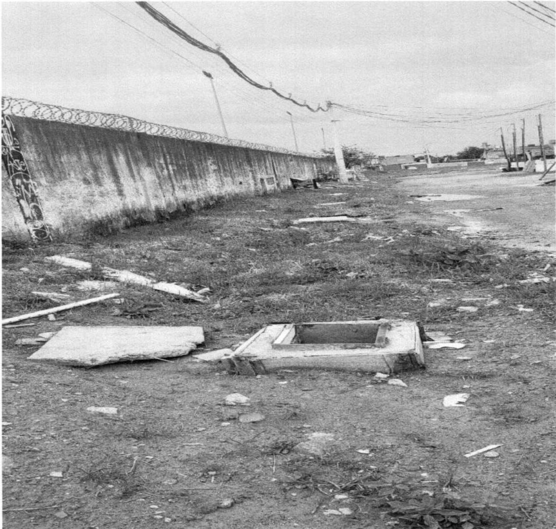
LIMPEZA EM TODA A EXTENSÃO DA RUA PROJETADA, VILA ESTAÇÃO – MOGI DAS CRUZES.
